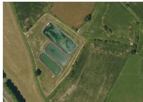
Les lagunes d'épuration de Baigts de Béarn
