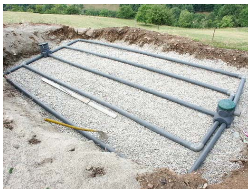
Dispositif d'ANC en cours de réalisation
